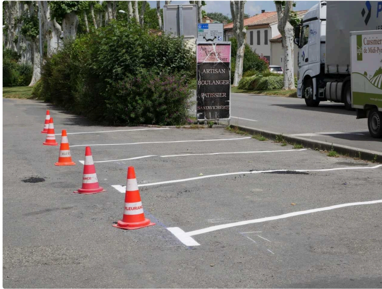
Des marquages au sol pour renforcer la sécurité
