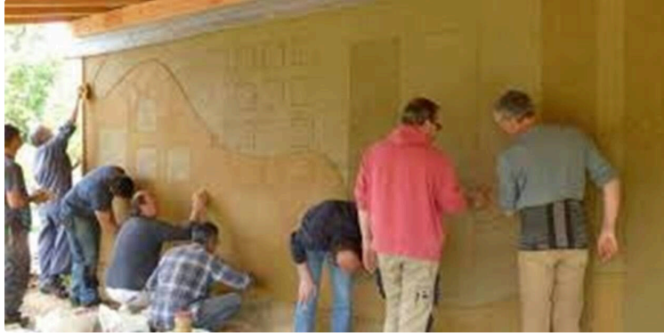
Façonner les enduits de corps en terre crue
