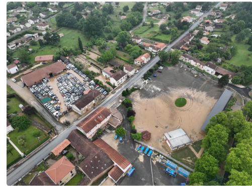
pompiers orages 964 .jpg
