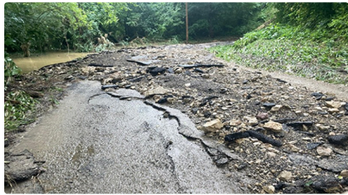
pompiers orages 961 .jpg
