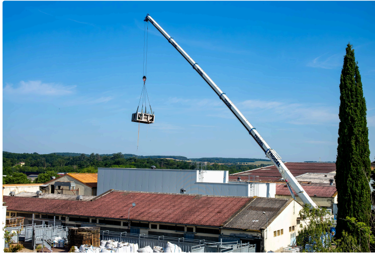
Abattoir : les travaux d'aménagement de la future chaîne d'abattage ont commencé
