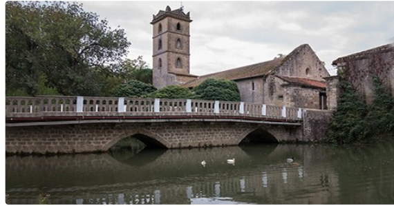
Surveillance de l'état des ponts
