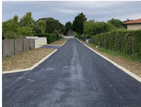
condom travaux 3.jpg
