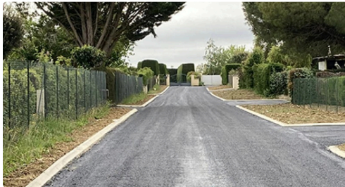
condom travaux 2.jpg
