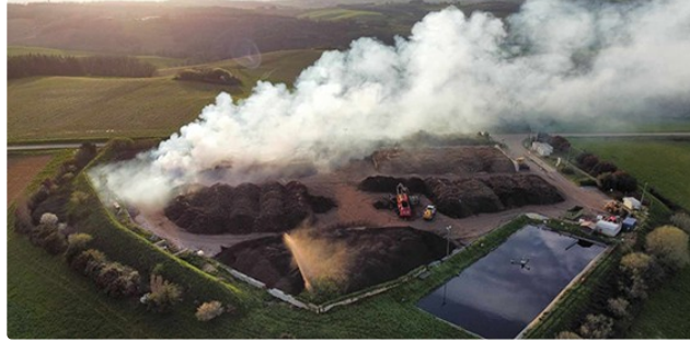
Incendie du site industriel de Castéron
