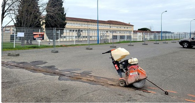
Info : début des travaux d'une ombrière à la Halle des Sports de L'Isle-Jourdain.
