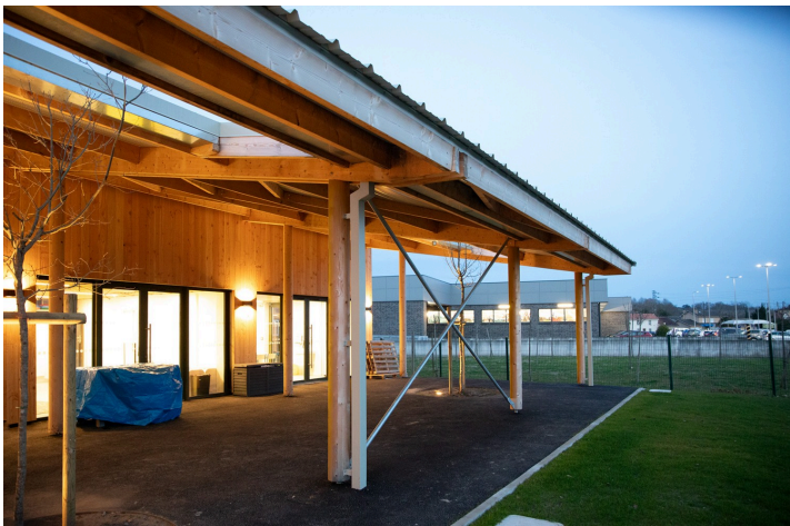
Une partie du large auvent
