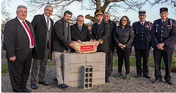
Pose de la première pierre du futur centre d'incendie et de secours.
