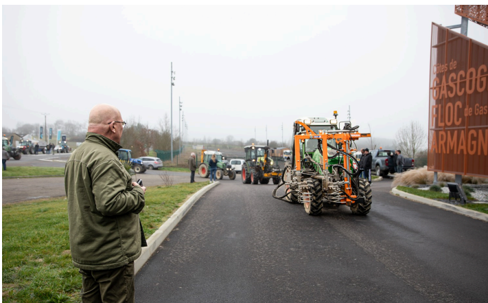
Les premiers engins atteignent le terre-plein de la Maison du Vignoble Gascogne Armagnac; à gauche, Bernard Malabirade
