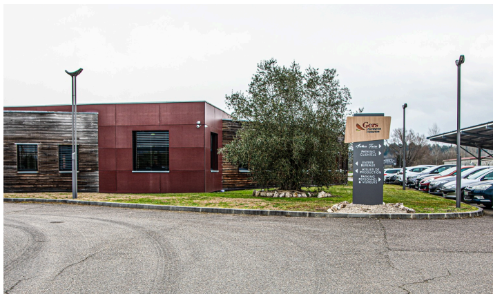
Le bâtiment des bureaux
