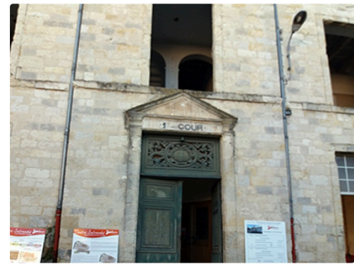
condom salvany travaux 2.jpg
