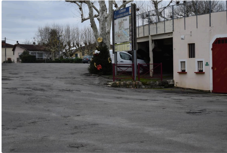
Les travaux ont commencé place Alban Dulhoste
