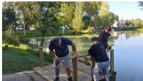
peche travaux en cours 2.jpg
