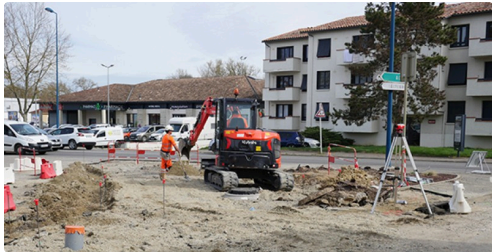
fleurance travaux 2.jpg
