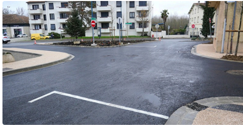
fleurance travaux 689.jpg
