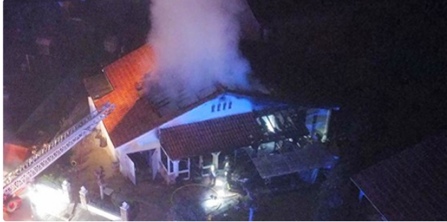
Alerte sur les risques d'incendie
