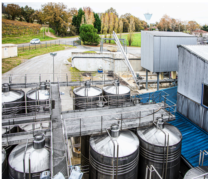
Vue sur les cuves les plus basses
