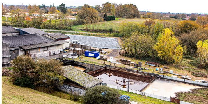
Au 1er plan, le réceptacle des effluents ; en arrière-plan, le champ photovoltaïque
