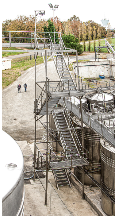
Cet escalier mène en haut des cuves à claire-voie (à 25 m)
