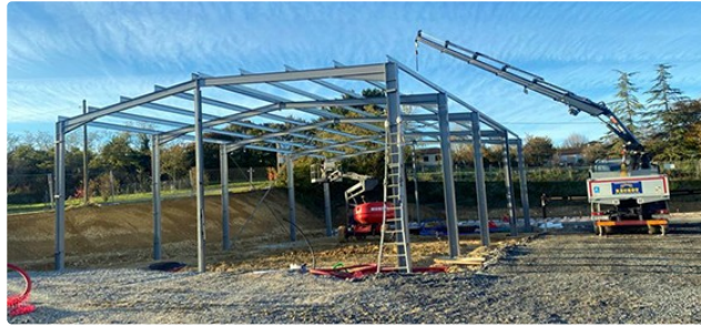
Le futur centre de secours prend forme
