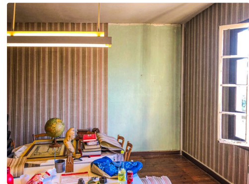
La salle du conseil pendant les travaux
