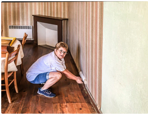
Pendant les travaux
