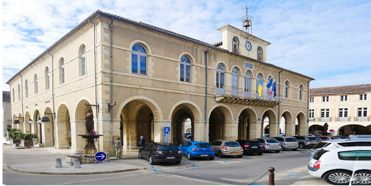
Travaux de l'Hôtel de Ville
