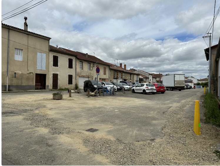
Les travaux du quartier des Tisserands sont lancés !
