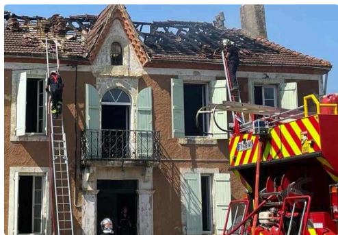
Castelnau d'Angles : feu de garage contigu à une maison d'habitation. Photo : SDIS 32.
