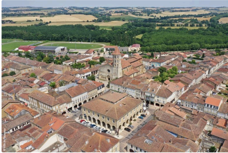
Des travaux de réfection de la voirie sont en cours à Fleurance
