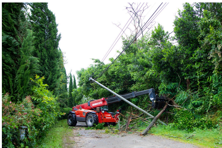
L'engin commence par évacuer l'arbre qui pèse sur le poteau
