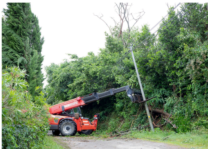
Puis l'engin redresse le poteau
