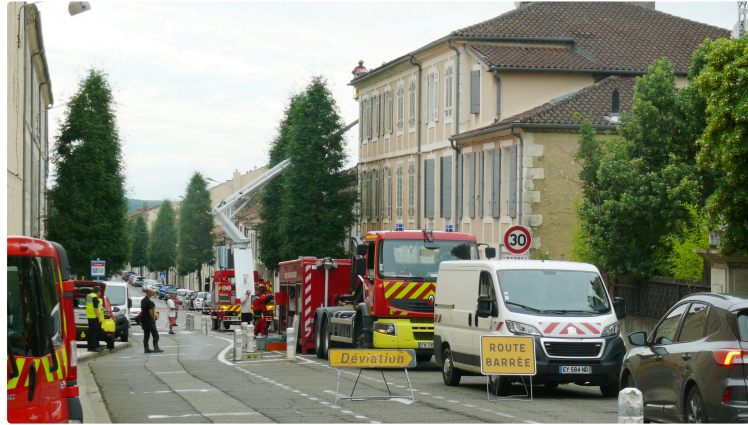
La cheminée s'effondre sur l'immeuble du voisin
