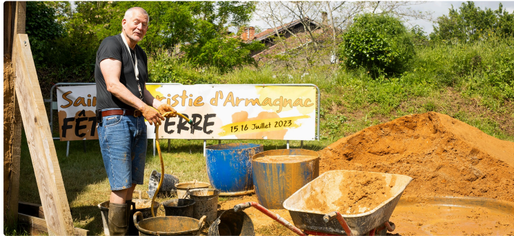
À Sainte-Christie-d'Armagnac on fabrique des adobes pour le four qui produira du fer
