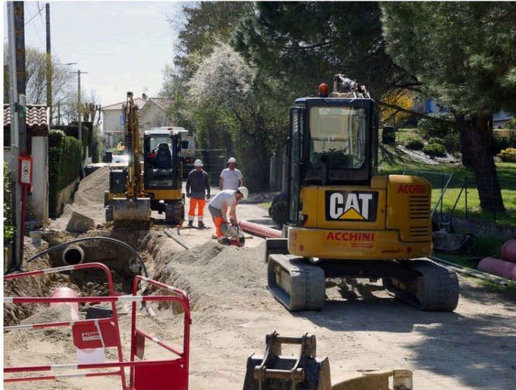
Mise aux normes du système d'assainissement – secteur Caouette
