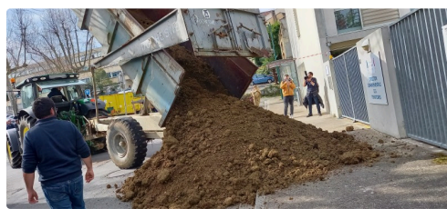
Premier camion à verser la terre.
