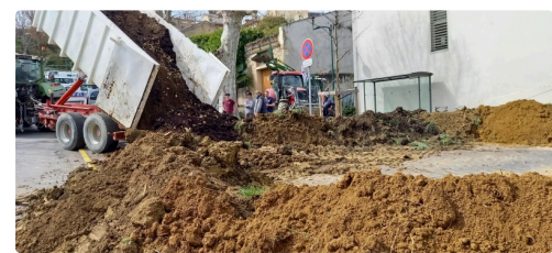
La retenue d'eau est quasiment terminée.
