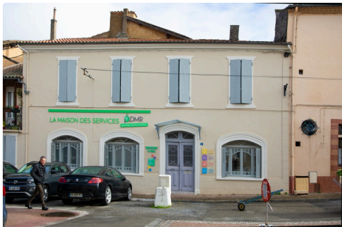
La Maison ADMR Gers Ouest place Alsace-Lorraine à Nogaro
