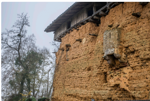
Le rempart en terre crue; "l'excroissance" en pierre correspond aux latrines aménagées à la Renaissance
