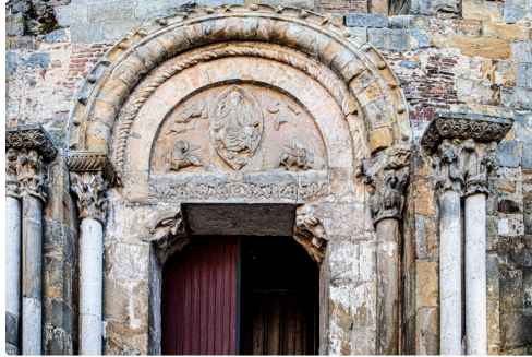
Le portail est de l'église de Nogaro avec la protection métallique de l'arc
