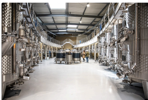
Intérieur de l'atelier des cépages
