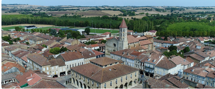
Réunion publique – Mise en place d'un réseau d'assainissement
