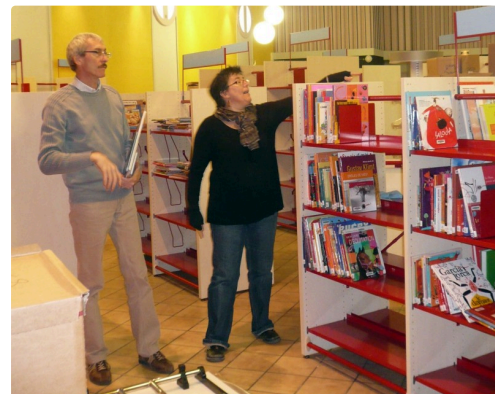
installation de la médiathèque du colisée
