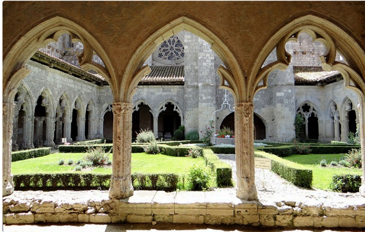
Un chèque de 273 000 euros pour rénover la Collégiale Saint-Pierre de La Romieu.
