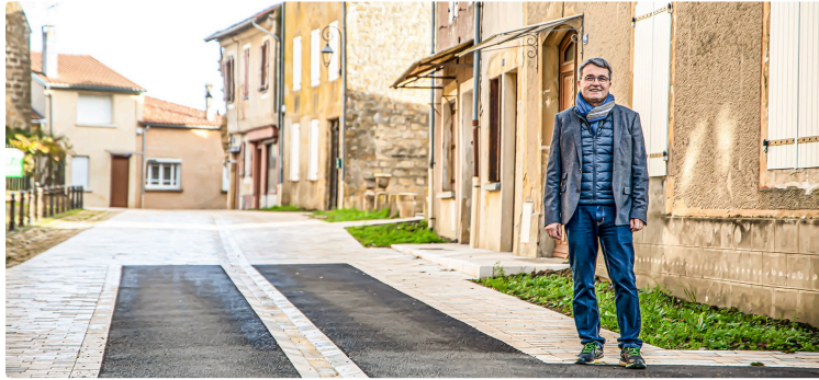
La rue Saint-Saturnin à Aignan: une belle rénovation très attendue
