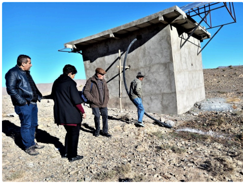
Et voilà le résultat d'un forage
