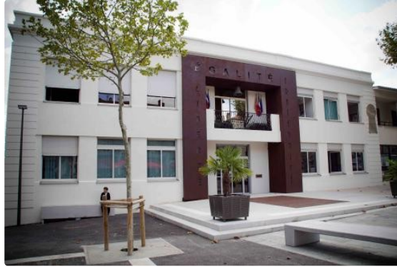
Rénovation énergétique de l'Hôtel de Ville : les travaux débutent bientôt
