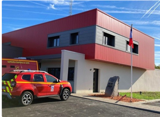
Nouveau centre d'incendie et de secours
