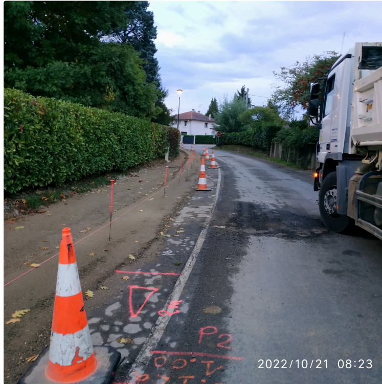
Les travaux sur le chemin de ronde avancent.
