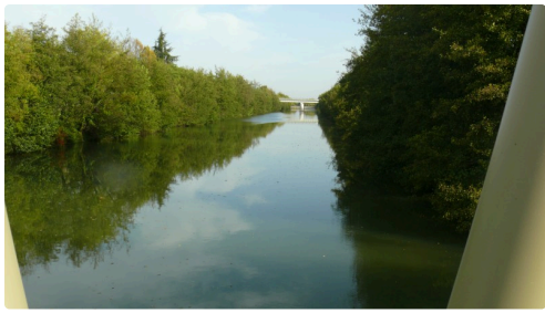
Vue sur le pont près du barrage.
