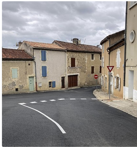
Les travaux de voierie avacent
