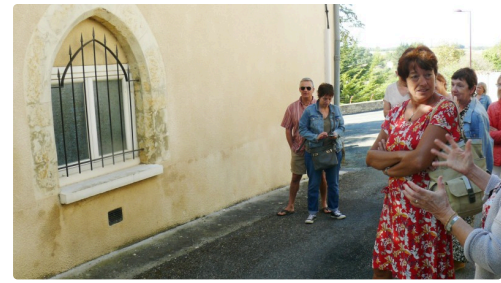
Baie en arc brisé, il s'agirait d'une porte médiévale (14e/15e s)
