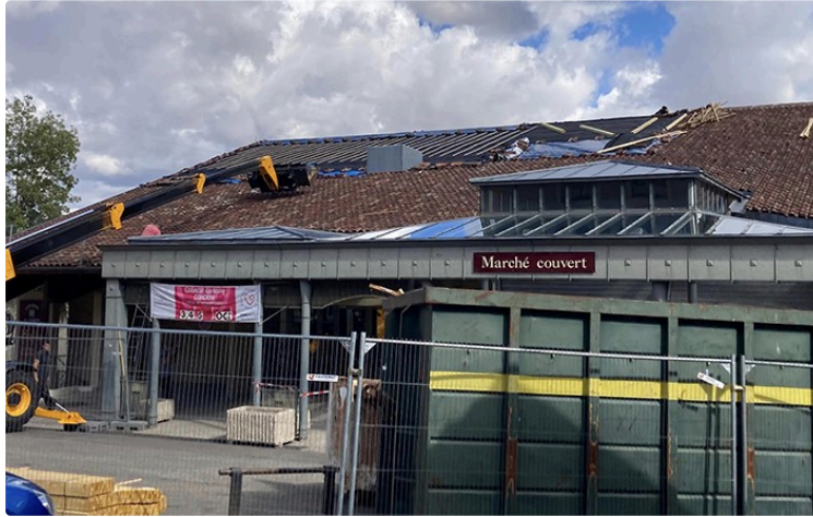
Travaux de la halle c'est parti
