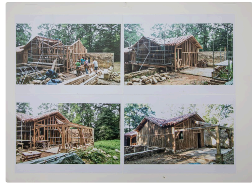
Photos des travaux du moulin exposées pour l'occasion
