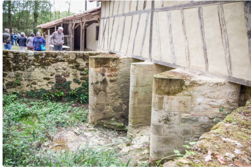
Les soubassements du moulin où l'eau tourbillonnait
