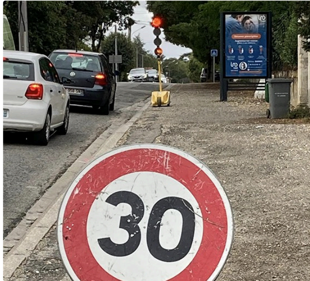
Les travaux de voierie avacent
