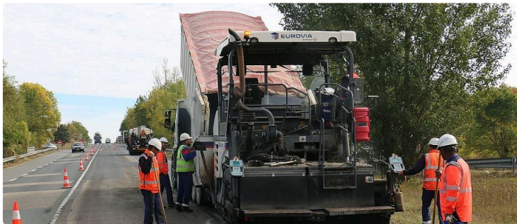
Travaux sur la RN 124
