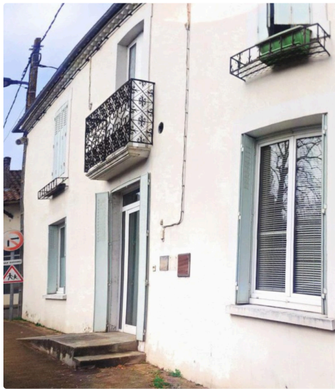
Le cabinet médical du CISAA à Riscle (photo extraite du site de la CCAA)
