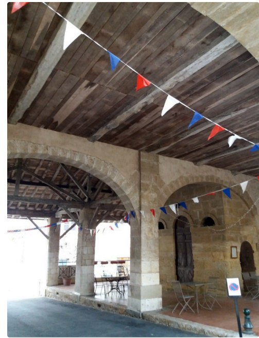
jegun halle 2.jpg
